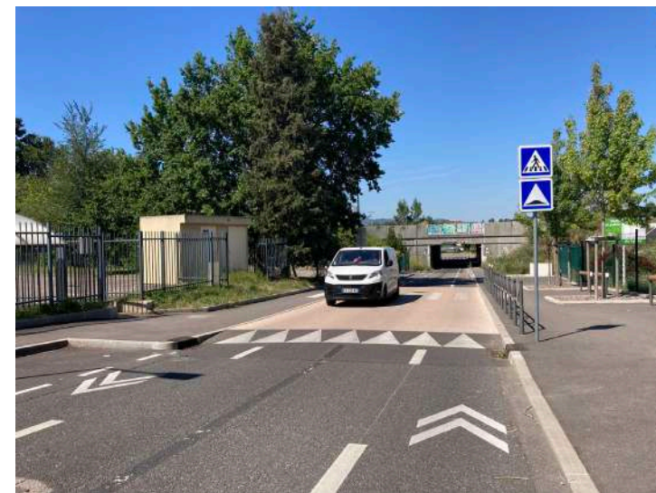
Chaussée à voie centrale banalisée à Dardilly (69)
