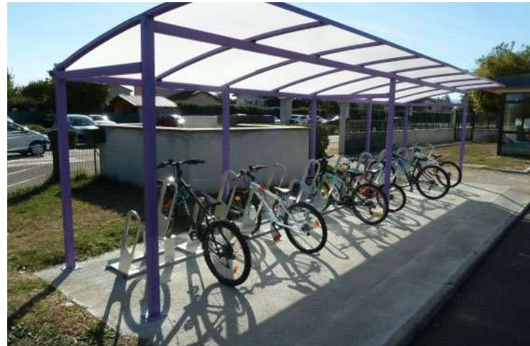
Abri vélo ouvert dans une école à Bonson
