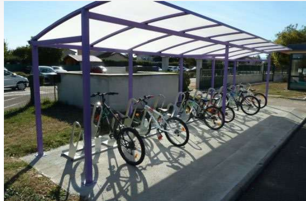
Abri vélo ouvert dans une école à Bonson
