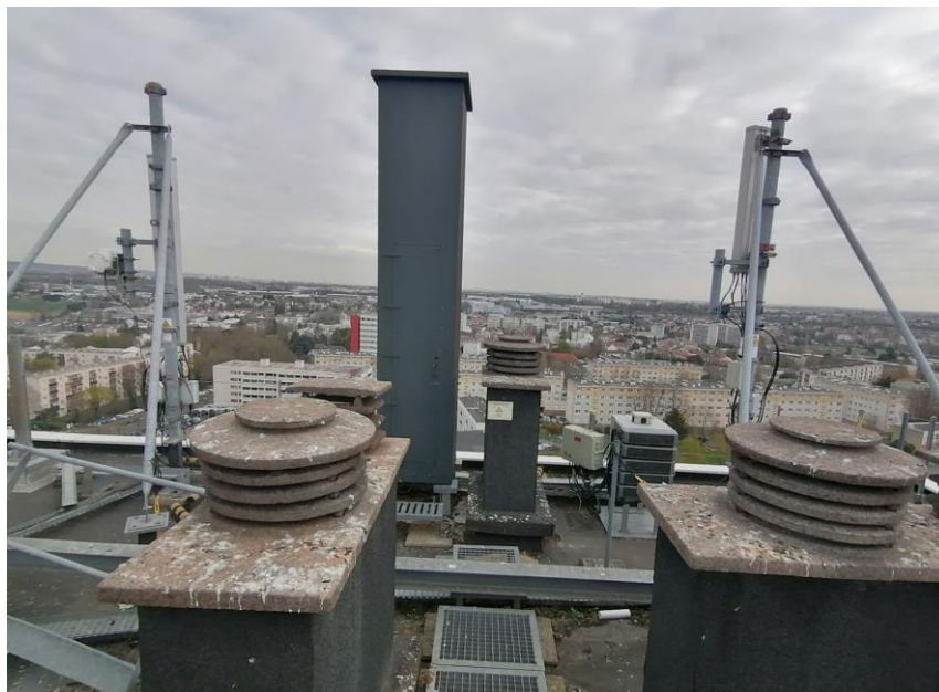
Vue de la terrasse S0 avant travaux
