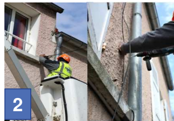
2 La fibre pénètre discrètement en façade
