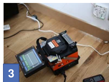
3 Soudure de la fibre pour la relier au réseau
