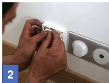
2 Installation de la Prise Terminale Optique (PTO) près du téléviseur principal
